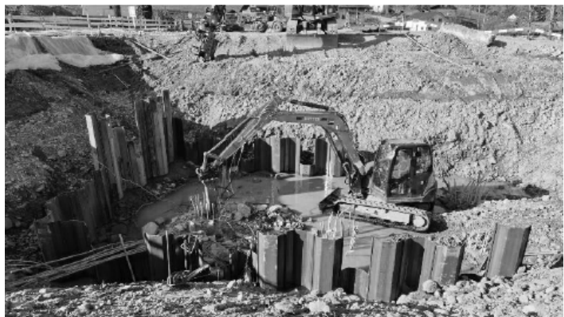
Aushub für die Widerlager auf Seite Brädele
